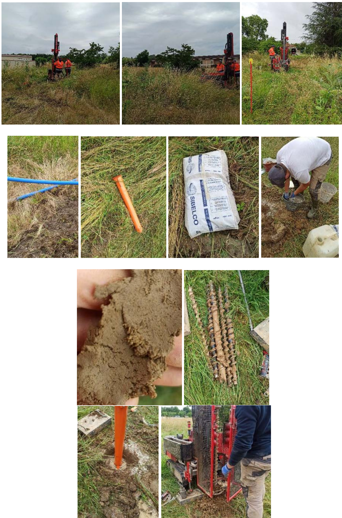
Figure 20 : Photographies de l'implantation du sondage SD1 / Pz, de son équipement et du sol rencontré au droit de celui-ci
